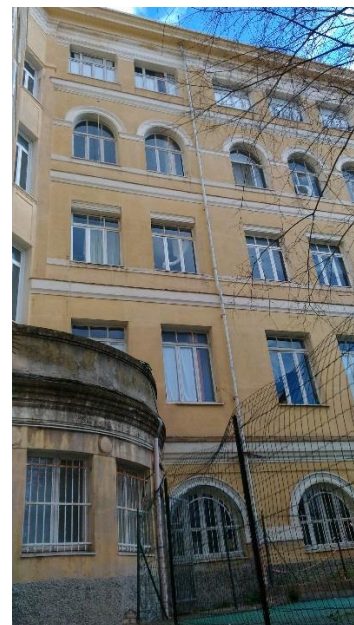
Figura 1.1 - Vista della facciata esposta a Ovest
