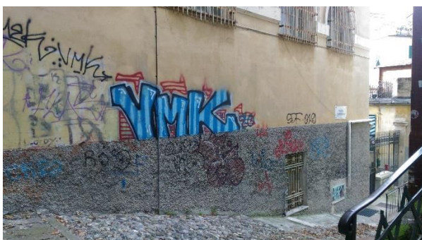
Figura 4.1 - Particolare della porzione di involucro
