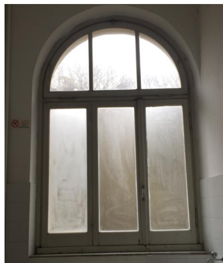
Figura 4.4 - Particolare dei serramenti
