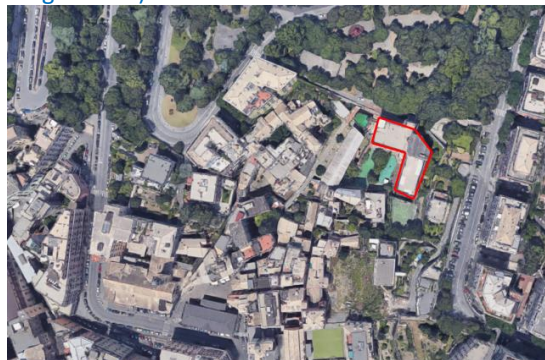
Figura 2.2 - Vista satellitare dell’edificio (Fonte: Google Earth)
