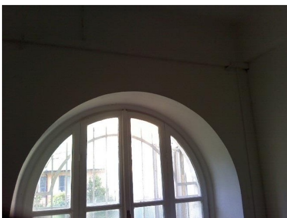
Figura 4.5 – Rilievo termografico dei serramenti
