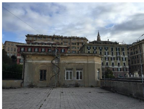
Figura 4.2 - Particolare della copertura
